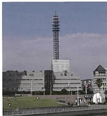
建物とのバランスを考慮した、シンプルなデザインの電波塔としている。(神奈川県横浜市)
