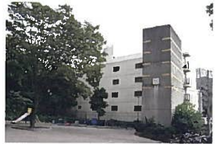
地下鉄の排気塔を公園内に取り込み、一体的な整備を行っている。(神奈川県横浜市)
