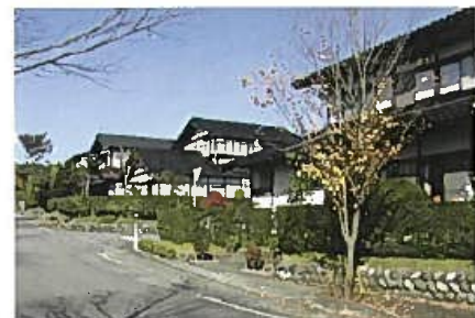
区画ごとに小規模な擁壁を設けて大きな構造物が生じないようにしている。(八尾町)
