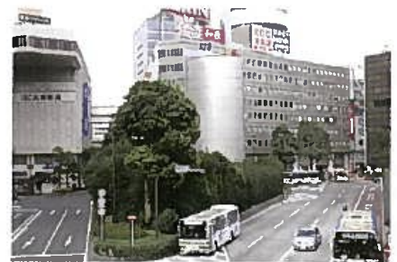
排気塔をパンチングメタルで覆い、都市空間に調和させている。(神奈川県横浜市)
