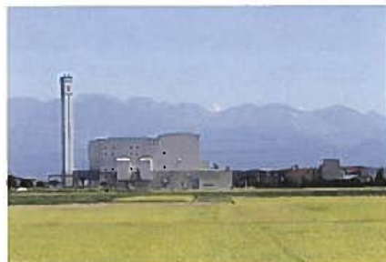
ゴミ処理施設に付帯する煙突は、建築とのデザインの調和が図られている。(新湊市)
