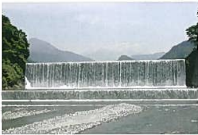
本宮砂防ダム(立山町) 国登録有形文化財に指定されている昭和初期の砂防ダム
