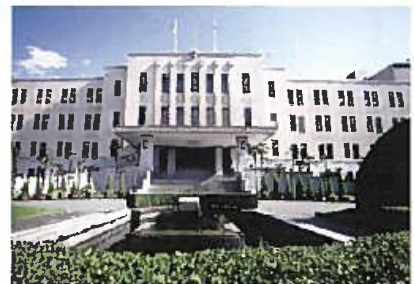
富山県庁舎本館(富山市) 昭和10年に建設された重厚な建築物
