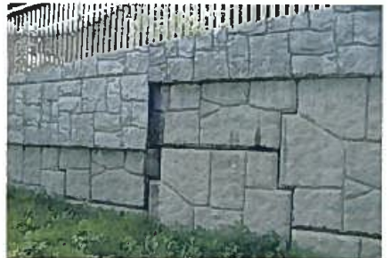
擁壁の表面の仕上げを自然石風とし、親しみやすさを創っている。(東京都多摩市)
