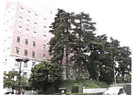
前面道路と建築物の間にボリュームのある緑を残して配置されている。(栃木県宇都宮市)
