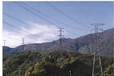
送電塔の表面仕上げを茶色とし、自然景観への影響を軽減している。(福光町)
