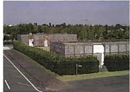
浄化槽の周りを植栽と木格子で囲い、違和感を軽減している。(富山市)
