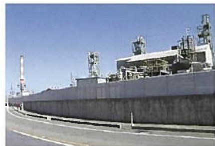
石積み風の擁壁とルーバーの組み合わせにより、歩行者への圧迫感を軽減している。(入善町)
