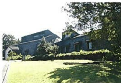
鉄筋コンクリートの躯体にウッドシングルを葺いて自然景観に調和させている。(婦中町)
