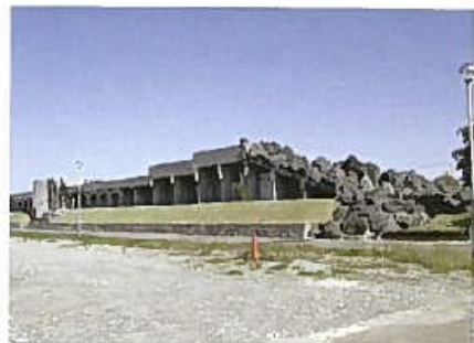
コンクリートの擁壁を自然石で修景し、周辺の景観に調和させている。(黒部市)
