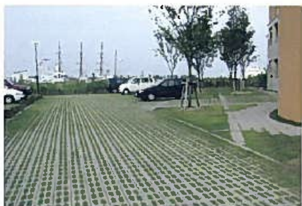
緑化ブロックを導入し、無機質になりがちな駐車場にうるおいを与えている。(新潟市)
