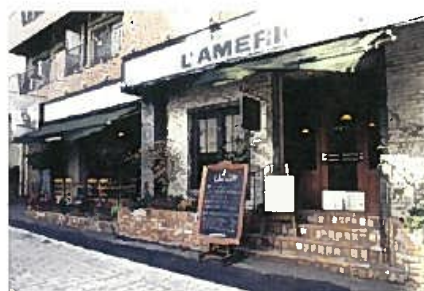
レンガなどの親しみのある素材を用い、商業地としての暖かみのある賑わいを演出している。(東京都渋谷区)
