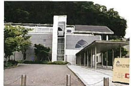
金属やガラスを限定的に用い、周囲の自然と調和しつつ、新たな景観を創っている。(立山町)
