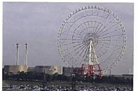
巨大な工作物の足元を緑化し、圧迫感を軽減している。(東京都江東区)
