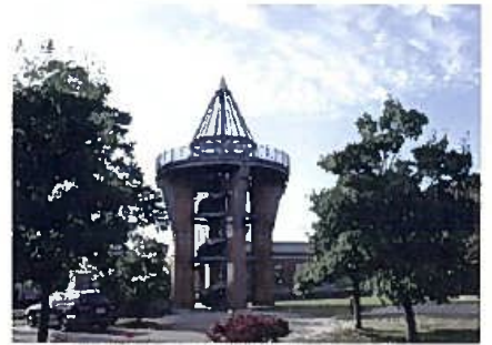
レンガを使って周辺の歴史的建物との調和を図っている。(入善町)
