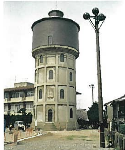
住宅へ光が直接当たらないよう、照明灯の位置を考慮している。(高岡市)
