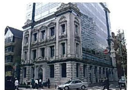
歴史的建築物の外壁の一部を残して、改築を行っている。(神奈川県横浜市)
