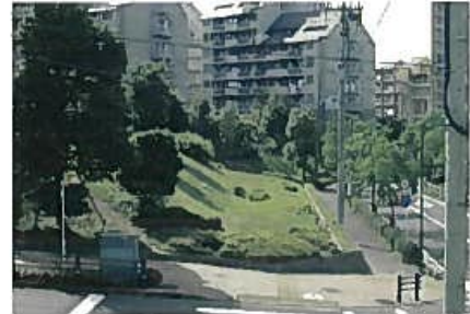
法尻にラウンディングを施し、緩やかな法面処理としている。(東京都多摩市)
