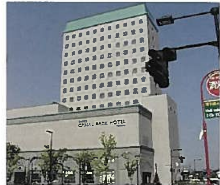
中高層部を壁面後退させ、中景レベルでの周囲への圧迫感、威圧感を緩和している。(富山市)
