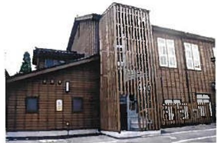
金属製の外階段を木の格子で覆い、木造建築との調和が図られている。(城端町)
