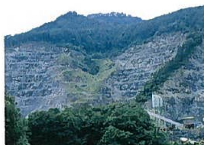
行為により、急傾斜の山肌が露出し、景観的に荒々しいものとなっている。
