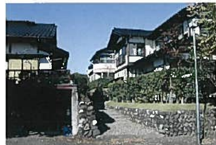
擁壁に地場の自然石を使用して造成している。(八尾町)
