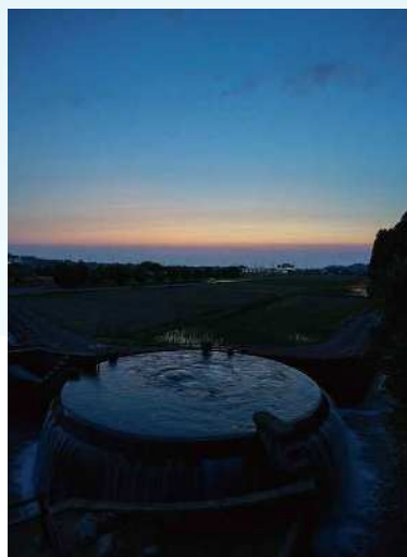
東山円筒分水槽 ～マジックアワーとともに～
