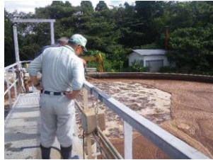
排水処理施設の確認
