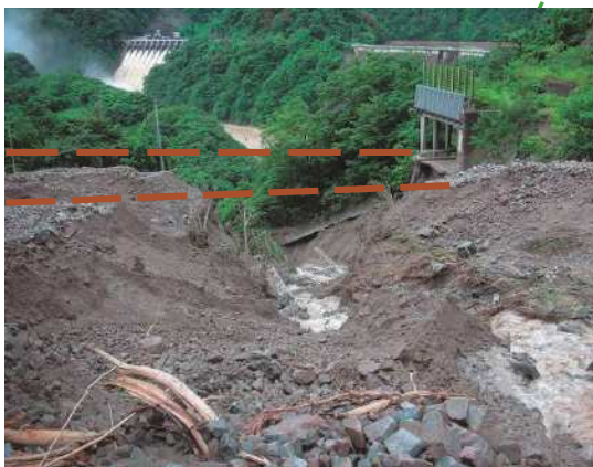
◆ そやま 祖山地区 南砺市／平成20年(2008年)7月 土石流により国道156号が被災。
