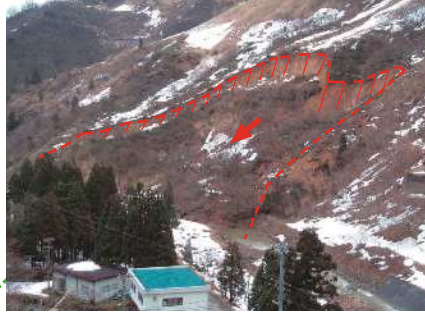
◆水須地区 富山市 地すべりにより河川が一部閉塞。
