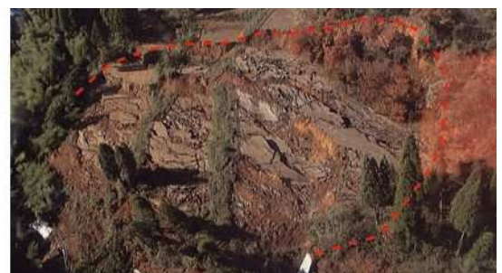
◆谷屋地内の地すべり
