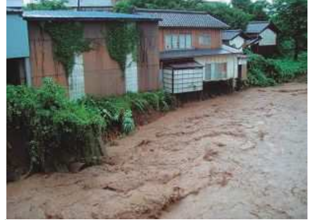
◆南砺市城端、出丸 池川の異常出水により、護岸が欠損、人家基礎が流出。
