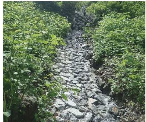
西五ノ谷の水路張石工
