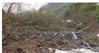
西ノ谷の石積堰堤
