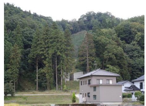
復旧状況：同左
