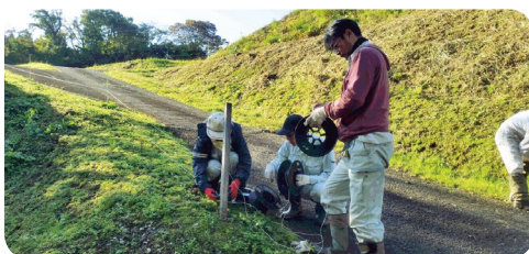
ボランティアによる電気柵撤去作業
