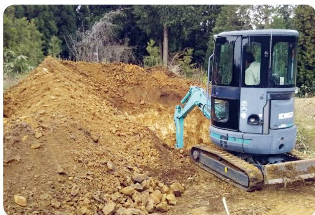
バックホーによる埋設穴の掘削
