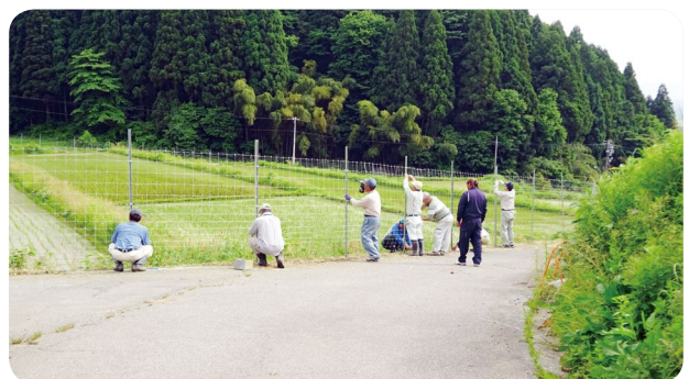
集落での耐雪型侵入防止柵の設置
