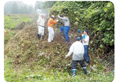
イノシシの侵入防止柵の設置
