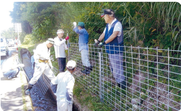
耐雪型侵入防止柵の設置
