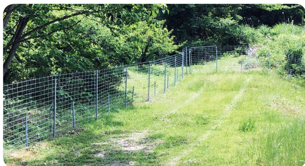
耐雪型侵入防止柵の設置
