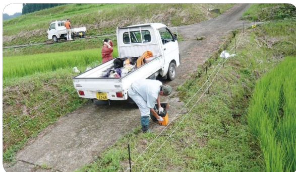
電気柵設置作業
