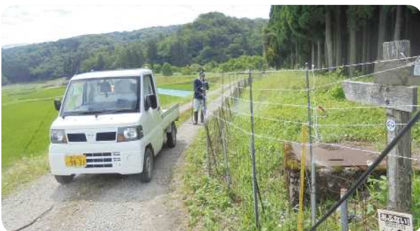
侵入防止柵維持管理状況
