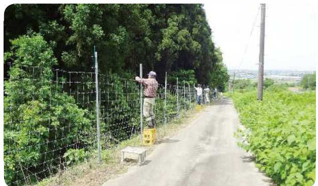
電気柵周辺の点検・修理
