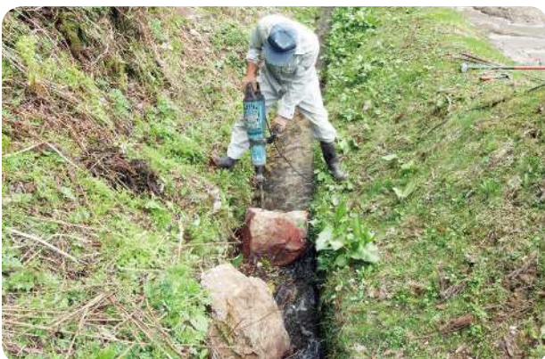
用水路内の落石除去
