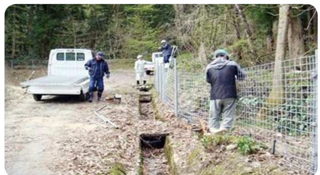
侵入防止柵設置状況
