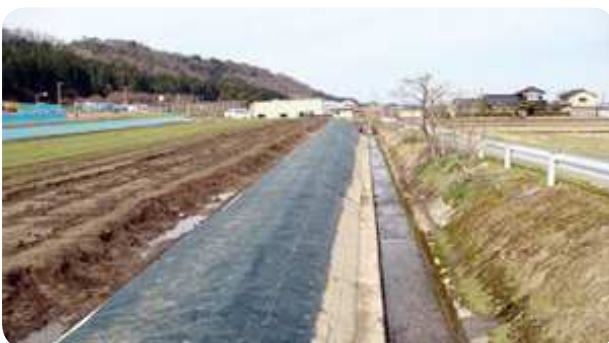
防草シート設置状況
