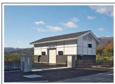
山田新田用水発電所（南砺市）
