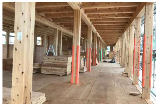
普通教室廊下からの風景。地域材を有効活用するため、木材断面を最小限に抑える方法として、燃えしろ設計とする構造躯体は最上階の小屋組みや見せ場となる独立柱のみに限定し、その他は石膏ボードによる防火被覆。床は魚津市産杉板WPC加工フローリング。
