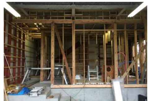
左上／LDKの造作家具（ベンチ）。杉をふんだんに使いながらも上品な空間を演出。 上／外観。 下／施工途中。主要構造は鉄骨だが、内部構造材と下地材、内装に県産材を使用し温かい空間に仕上がっている。
