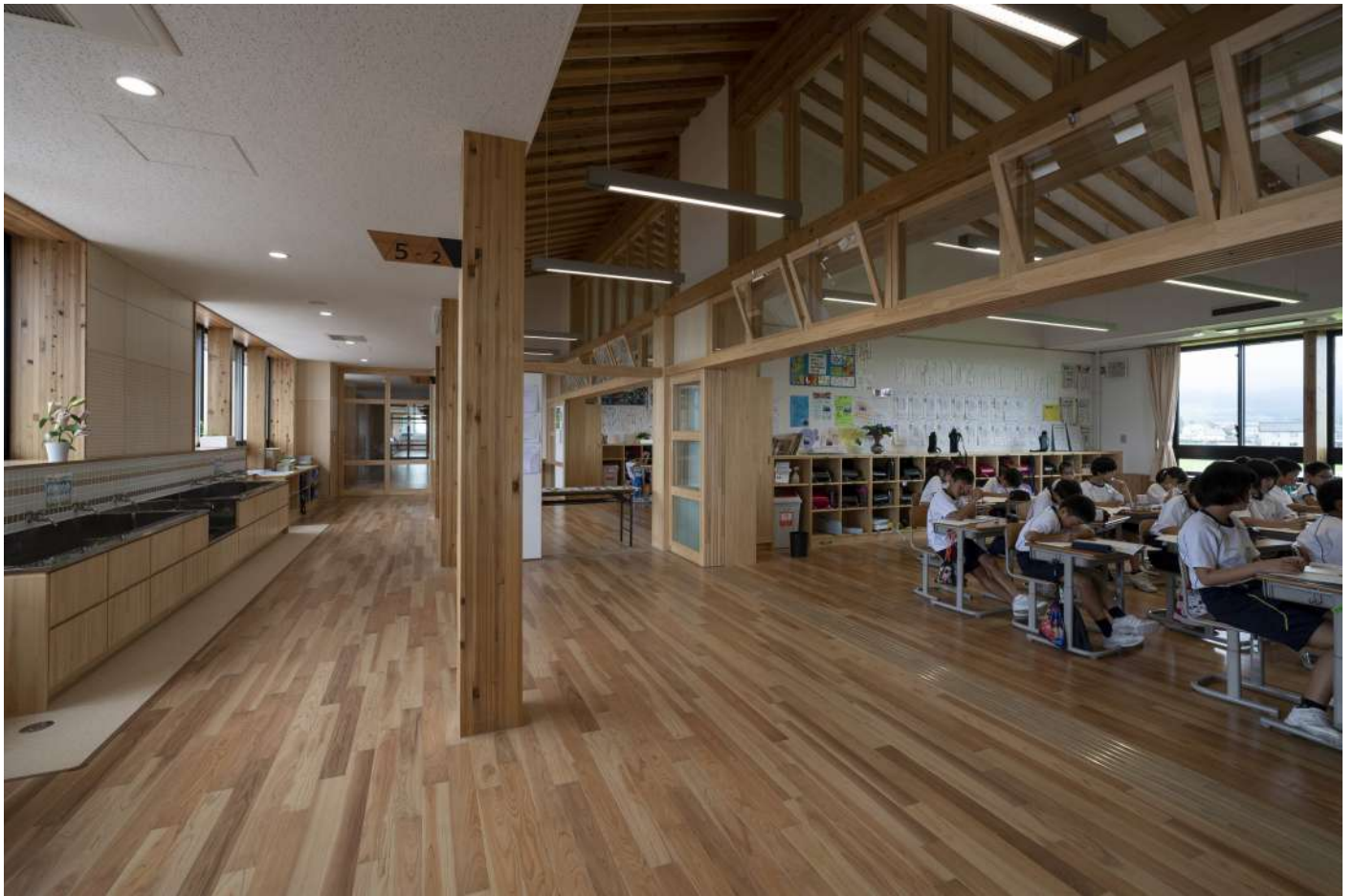
普通教室廊下からの風景。地域材を有効活用するため、木材断面を最小限に抑える方法として、燃えしろ設計とする構造躯体は最上階の小屋組みや見せ場となる独立柱のみに限定し、その他は石膏ボードによる防火被覆。床は魚津市産杉板WPC加工フローリング。
