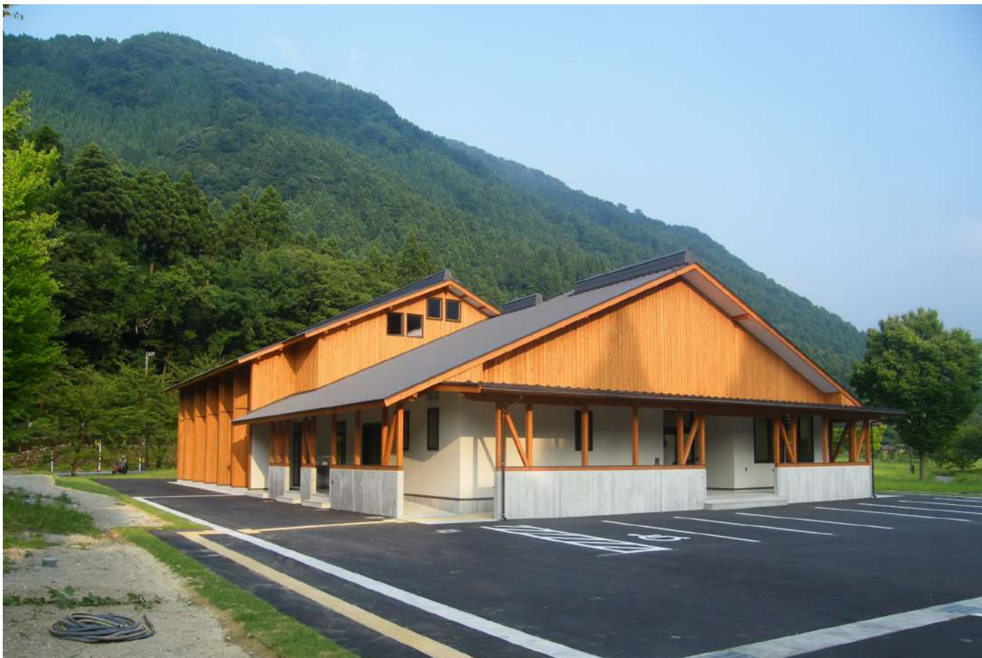
施設外観。明るい彩色の建物に、雁木によって入り口に誘導される。外壁は県産杉の縦張り。屋根は雪下ろし不要な落雪型とし、敷地の広さを活かし地上で機械処理できるようにするなどの配慮がみられる。
