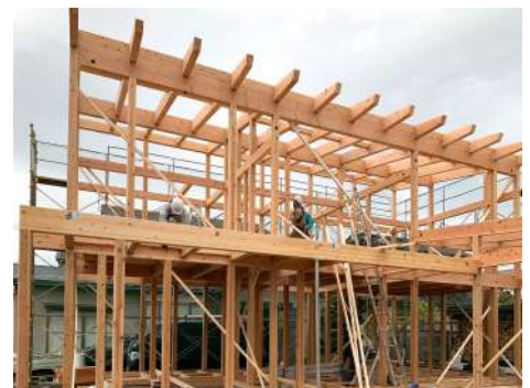
左上／部分的に柱面に合わせた一面板張りのデザインで空間を特徴づけている。 上／外観。古い住宅地と調和しながらも明るく爽やかな色彩。 下／南向きに軒を大きく梁だたせた登り梁。リズムカルで美しい架構を演出。
