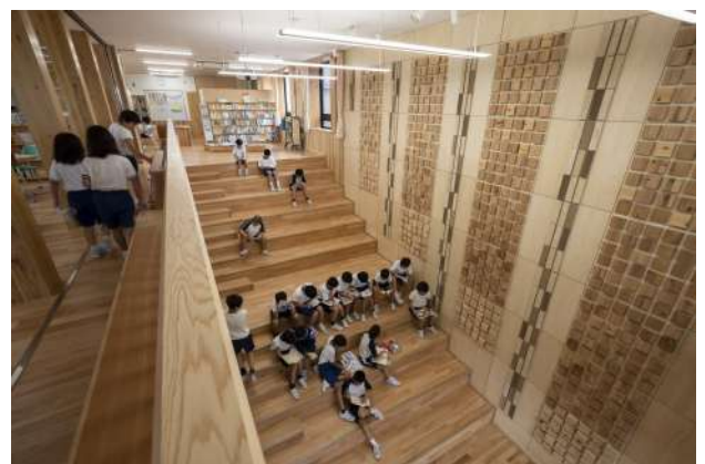
上／普通教室廊下の施工風景。柱・仕口は在来ブレイクにより加工可能な形状とし加工手間を減らした。耐力壁においては工場パネル化、金物は極力木造住宅用にするなど、コスト面への配慮もなされている。県内の事情を熟知した設計・施工といえる。
