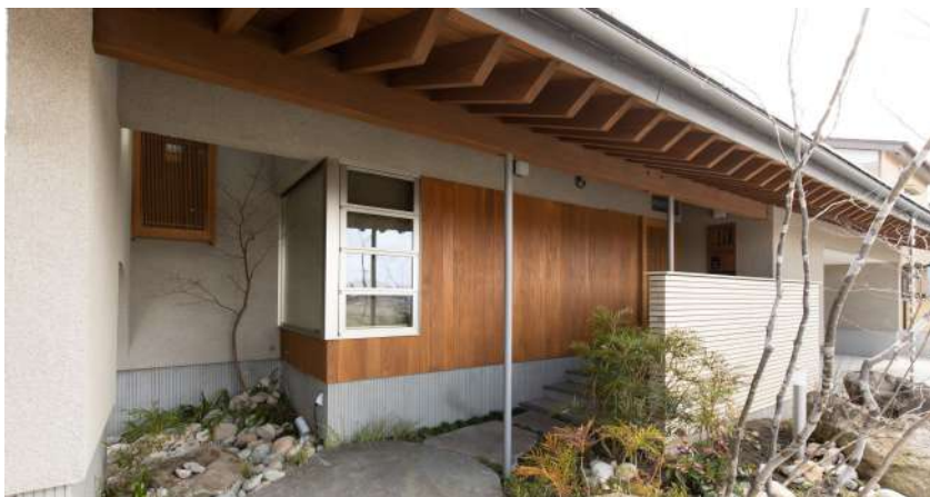
上／施工途中風景。桁間に落とし込まれたジョイスト梁で構成される屋根組が構造の特徴。この上に構造用合板を張ることで高い水平剛性を獲得するとともに、内部からの見た目を軽快にし美しい連続感を作ることができる。 下／低く深く持ち出された梁で彫りの深い表情をつくり、来客を招き入れる雰囲気醸し出す。大工の伝統的な継手を用いた県産杉材の軒桁とスチール製の独立柱を組み合わせた伝統とモダンの演出。
