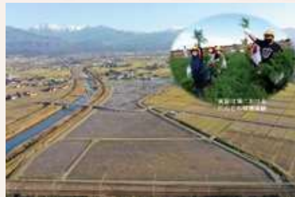
▲国営農地再編整備事業「水橋地区」における整備状況
