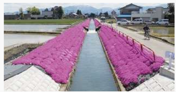
▲多面的機能支払交付金を活用した水路法面の植生(砺波市林地内)
