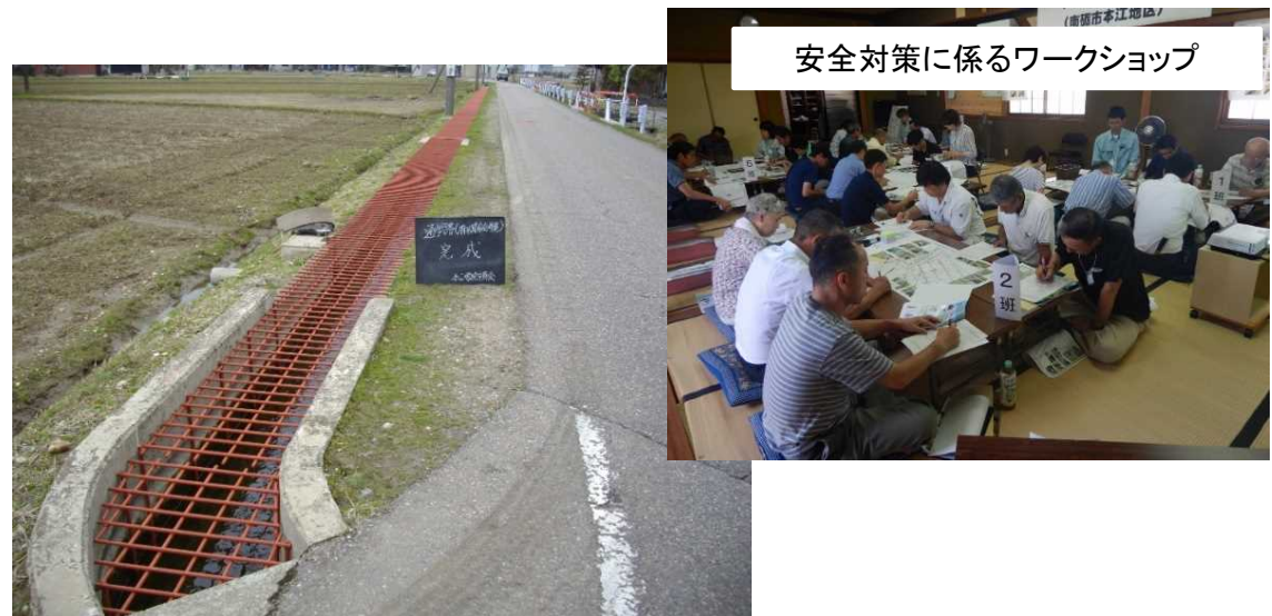
転落防止蓋の設置
