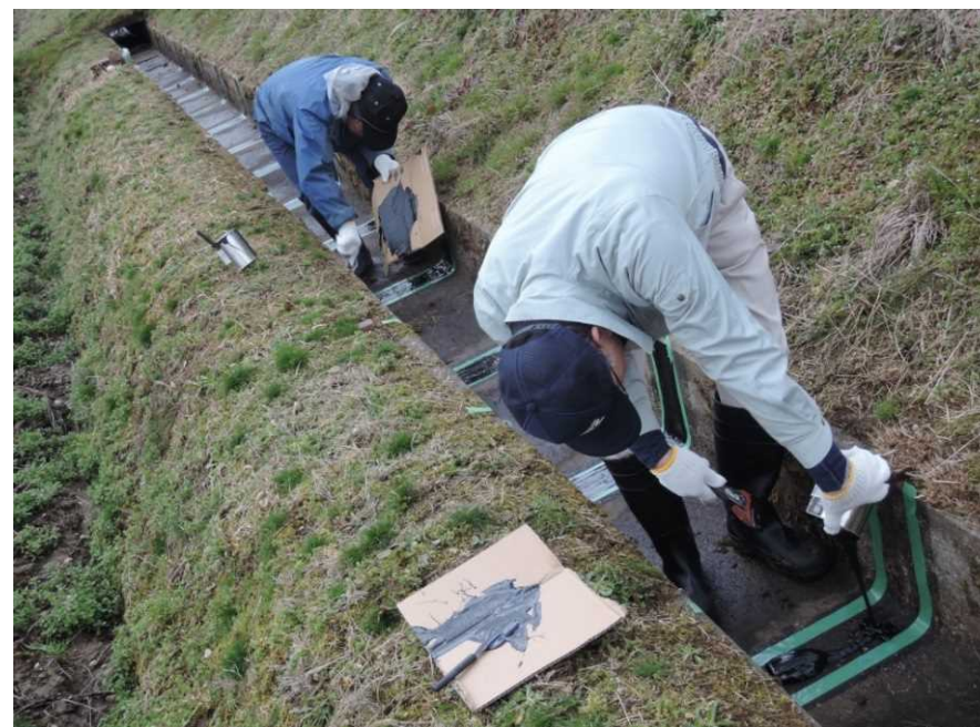
水路の目地補修
