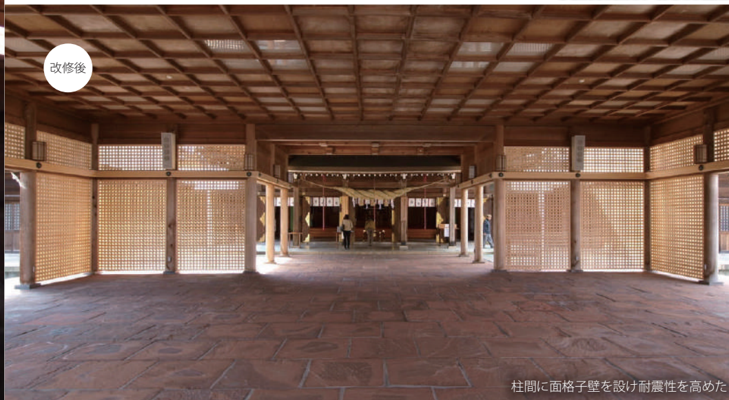
大屋根を柱だけで支える構造
