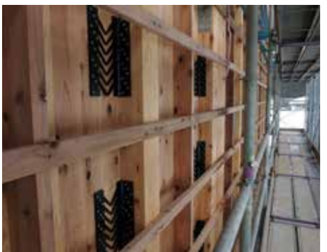
耐震性を高めるダンパー付きCLT耐力壁
