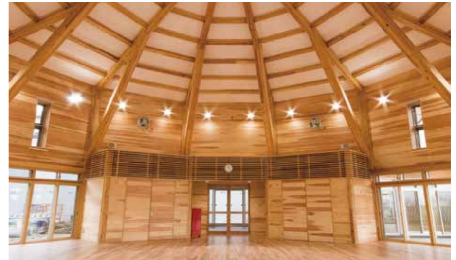
県産杉構造用集成材の梁柱を現しとした十二角形のホール。床には魚津市産スギのフローリング、壁は氷見市産のスギ羽目板を使用。
