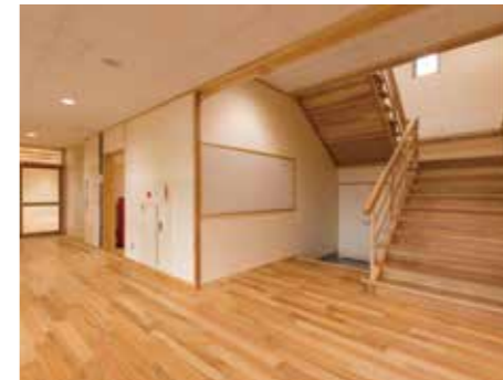
部室棟廊下・階段。建具、家具、踏板や手すり等、すべて県産材を使用。
