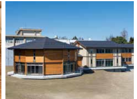
軒を出した勾配屋根と県産スギ羽目板外壁による木造らしさを打ち出したデザイン。
