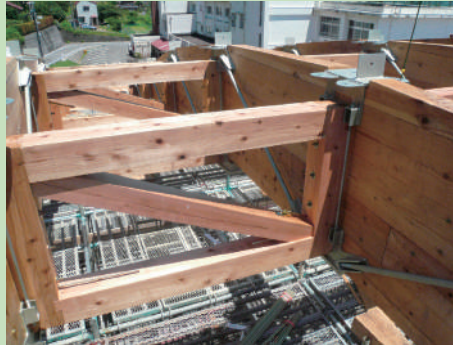
[写真2]アーチと横補剛ユニット材の納まり状況
