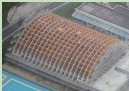
【写真1】建て方完了時の全景
