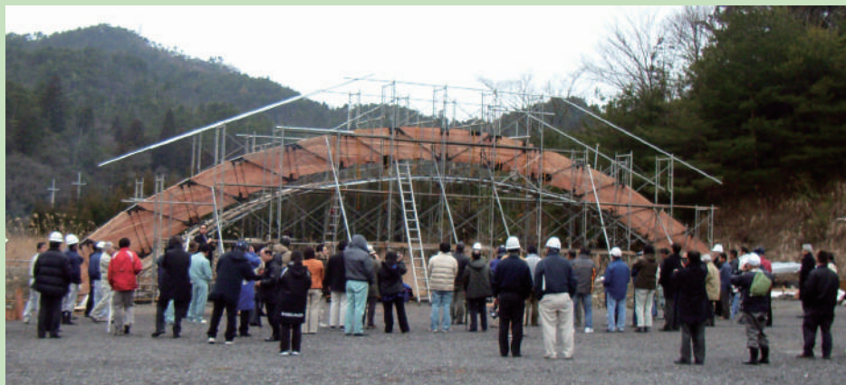
[写真3]アーチ梁の実大実験。偏荷重に対する挙動や施工手順の検証を行った。
