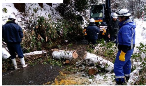
倒木撤去作業状況
