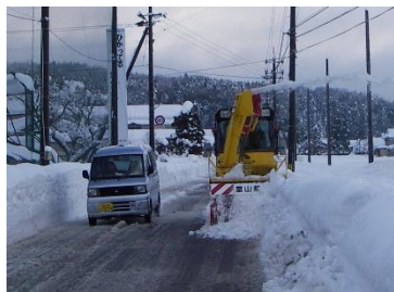
小型ロータリ除雪車による拡幅作業
