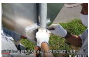
注意喚起看板の取付け
