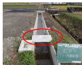
足場確保のため水口蓋の設置
