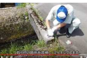
道路鉄の設置
