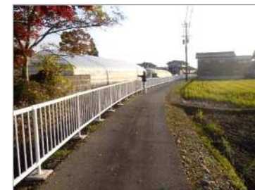
4号排水路（小矢部市金屋本江）
