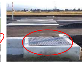
水路柵蓋の設置
