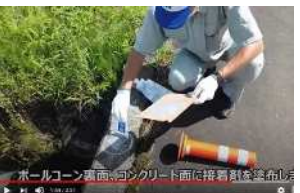
ポールコーンの設置
