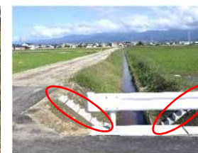
水路昇降用の階段の設置
