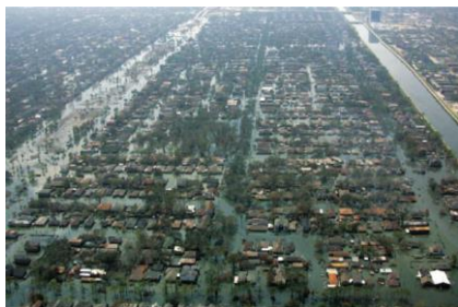
ハリケーンによる浸水被害 (アメリカ・ニューオーリンズ市)
