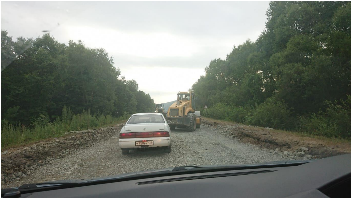
(写真4 道路の両側で工事をしている日本では中々ない光景)
