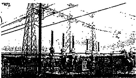
送電設備です
