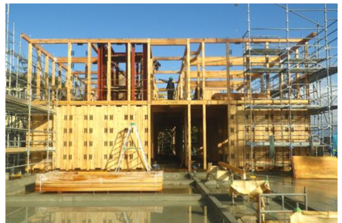
部室棟の建て方。CLT耐力壁を設置したところ。
