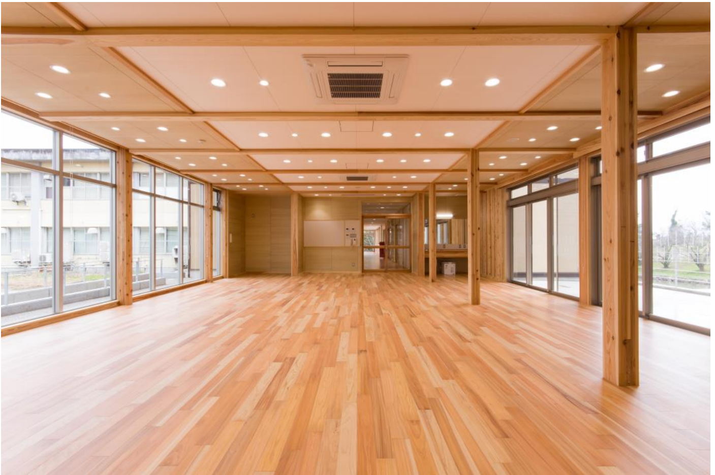
談話コーナー。利用者の目につくよう、構造の特徴である県産スギCLT耐力壁を一部仕上げ材として現しとした。外部に開かれたガラス張りと壁に採用された南砺市城端しけ絹の調和により、圧迫感のない木質空間に仕上がっている。
