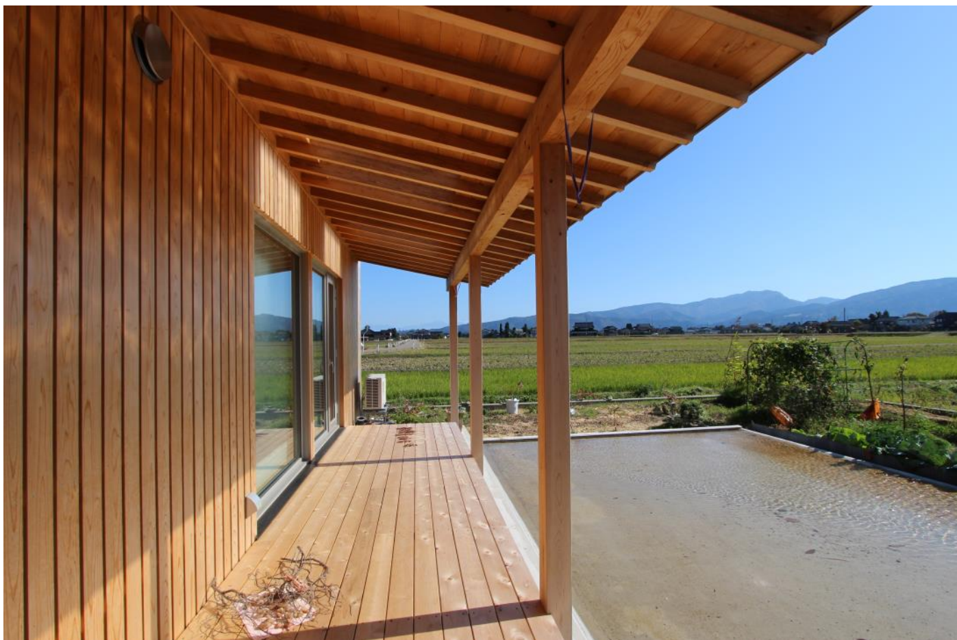
南面。外壁のファサードラタンは、透湿防水シートの上にスノコ状に杉板同士の間隔を開けて張ったもので、外壁内の通気性を確保することで日射熱を籠らせない。耐震等級3級と高気密高断熱（Ua値0.23/C値0.16）を備え、外装・外構は無塗装材を使用するなど、設計者である施主の挑戦が詰まった住宅。
