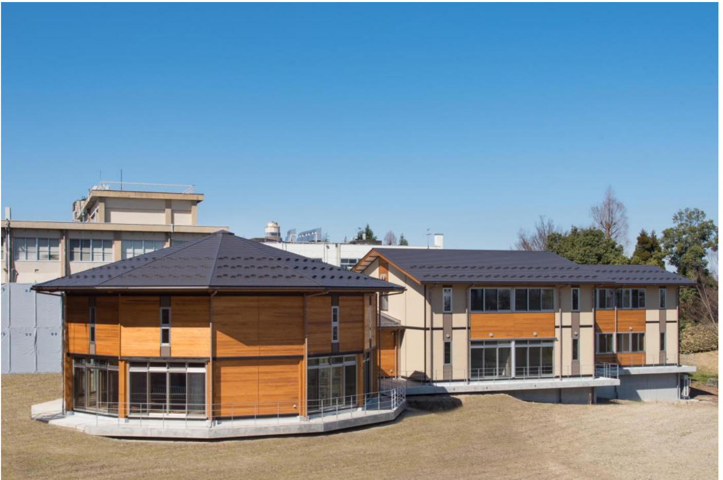
ホール棟・談話棟・部室棟の3棟構成とした、軒を出した勾配屋根と県産スギ羽目板外壁による、木造らしさを打ち出したデザイン。
