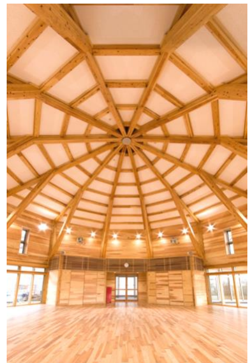
県産杉構造用集成材の梁柱を現しとした十二角形のホール。床には魚津市産スギのフローリング、壁は氷見市産のスギ羽目板を使用。
