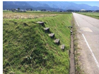
法面における階段の設置
