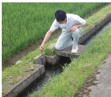
人力による水口水門操作
