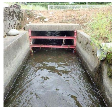
暗渠入口部の 簡易スクリーンの設置
