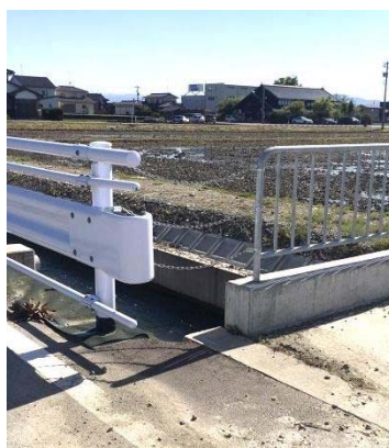
柵のすき間対策の実施による安全性の向上 (チェーン、ロープ等)
