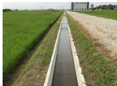
コンクリート水路
