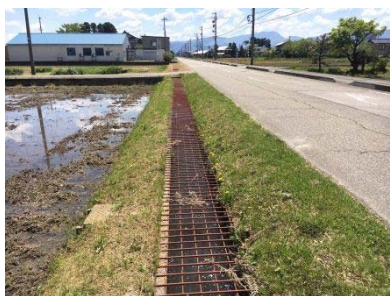
水路蓋(鉄筋網)
