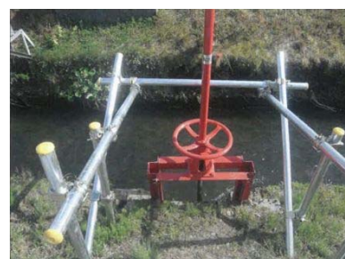
水門まわりの簡易安全柵の設置
