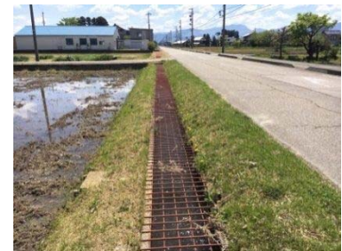
簡易な安全施設の設置
