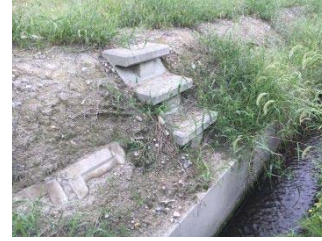
法面における階段の設置
