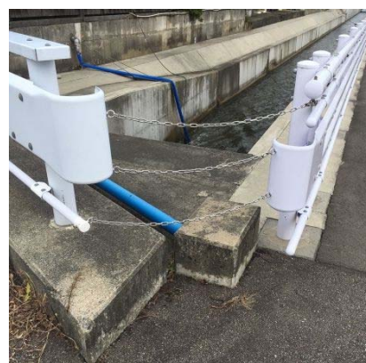
柵のすき間対策の実施による安全性の向上 (チェーン、ロープ等)
