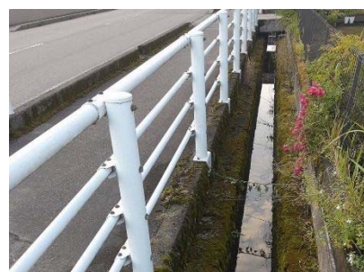
道路沿いの転落防止柵
