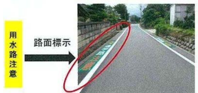
路面標示(ペイント)
