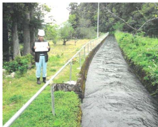
単管鋼管を用いた簡易柵
