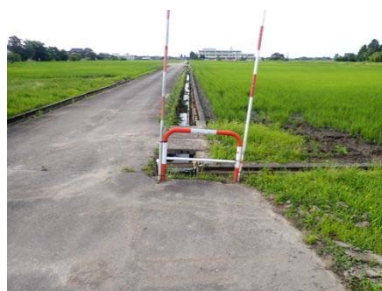
道路が狭小となる箇所への対策
