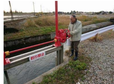
例6 水量調整のための水門操作作業
