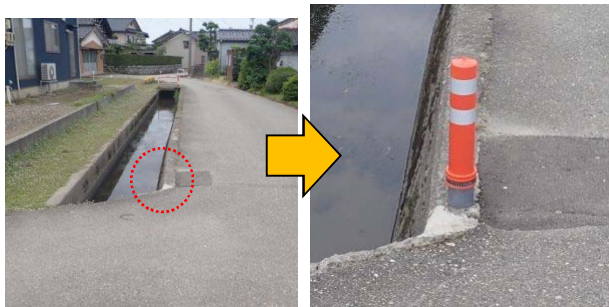
ポールコーンの設置
