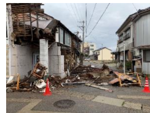
倒壊した家屋（氷見市）
