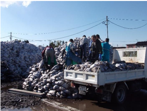
掘り出した土嚢袋が山のよう！
