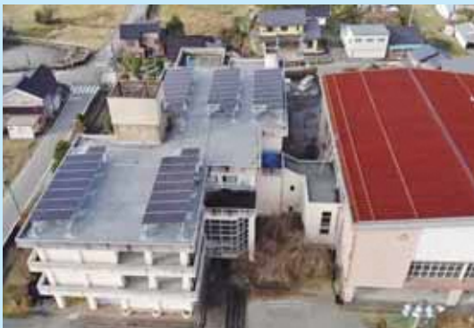
釜ヶ淵小学校校舎に設置した太陽光発電パネル(2019年8月整備)
