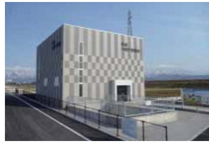
小水力発電所(小摺戸発電所(入善町))
