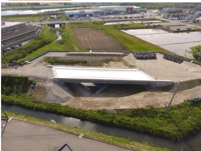
松原建設・篠川組 都市基盤河川馬渡川改修に伴う 橋梁上部工工事共同企業体 都市基盤河川馬渡川改修に伴う 橋梁上部工工事 発注者 富山市
