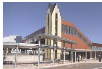
石動駅新駅舎・南北自由通路
