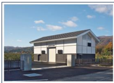
山田新田用水発電所（南砺市）
