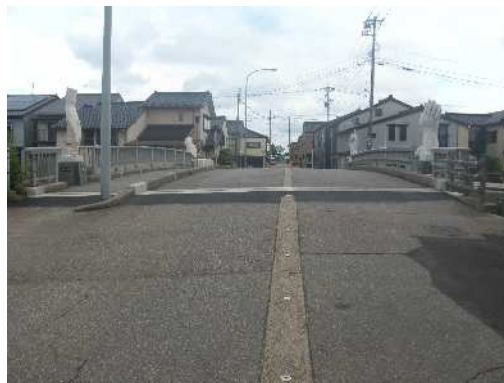
株式会社 牧田組 「市道放生津町立町線(山王橋) 橋梁補修工事」 発注者 射水市
