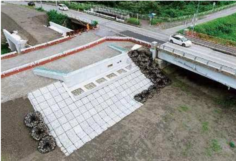
藤川建設(株)施工の「主要地方道富山魚津線道路総合交付金今川橋下部工（A1橋台）工事」
