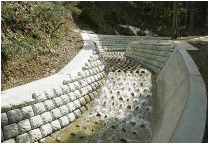
(株)松本建材施工の「小矢部川水系太美谷砂防関係施設整備（砂防） 護岸工その2工事」
