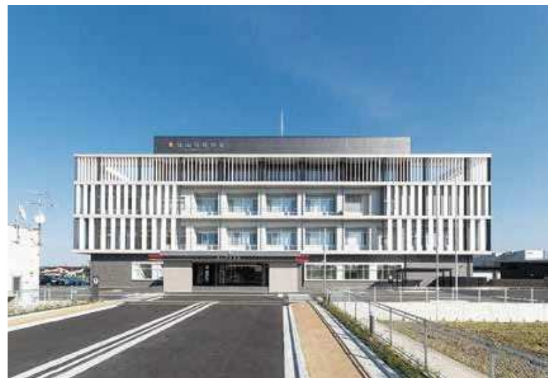
日本海建興・タカノ建設・三由建設（仮称）富山南警察署新築工事 共同企業体施工の「（仮称）富山南警察署新築工事」
