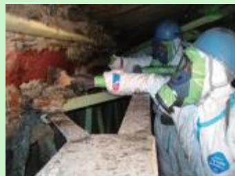
吹付け石綿の除去作業の様子
