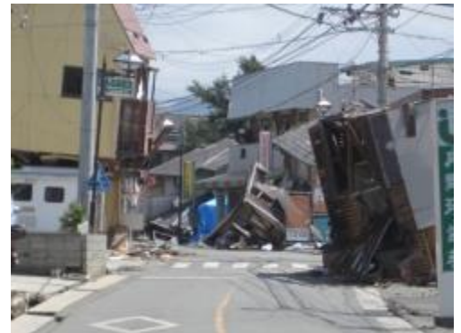
地震で損壊した建物
