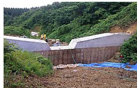
治山ダム工における残存型枠
