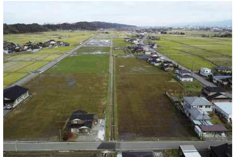
ケミコリバイブ(株)施工の「ほ場整備小長沢地区第2工区ほ場整備工事」
