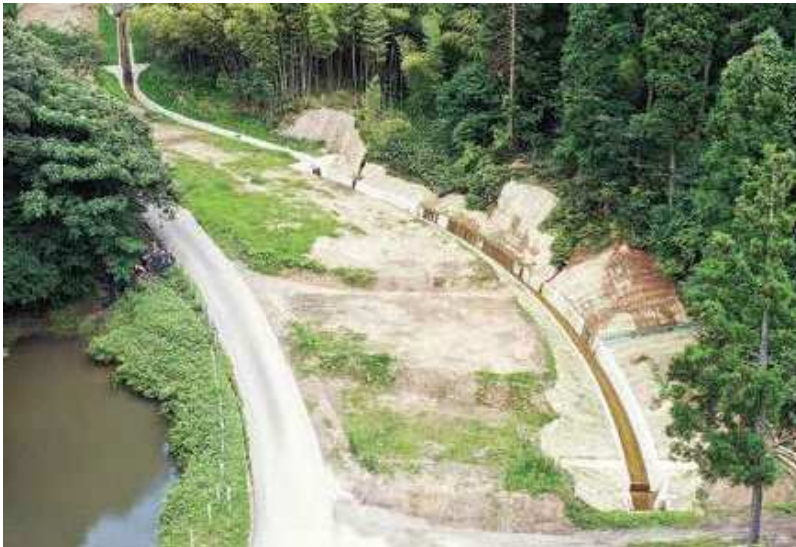
(株)早木工業施工の「山地災害重点太田流路工事」
