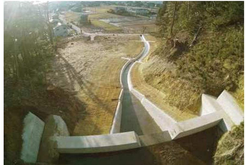
(株)花岡組施工の「防災対策総合治山「東山」溪間工事」
