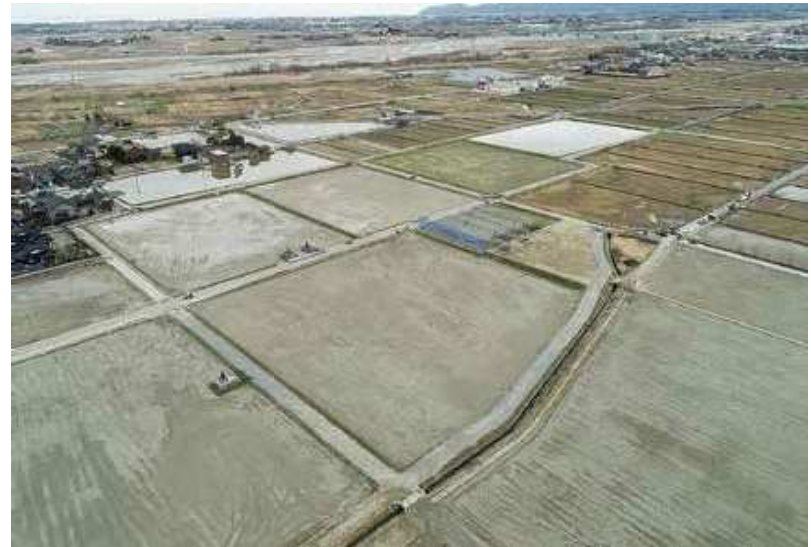
共和土木(株)施工の「ほ場整備出島地区第1工区ほ場整備工事」
