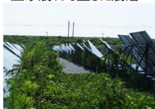
放置されたパネルの現況
