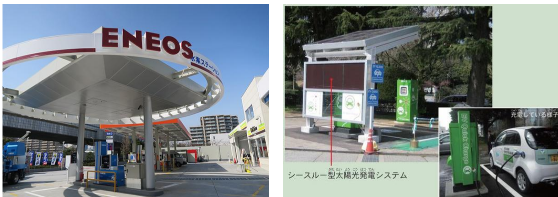
【給油所に併設された水素ステーション（左）／富山県庁に設置された急速充電器（右）】
