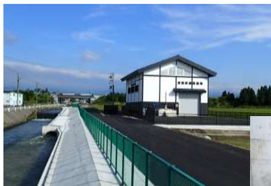
常西幹線発電所 (R2.7 運転開始)
