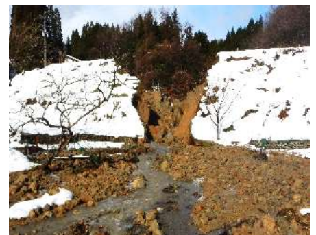
破堤したため池（氷見市）
