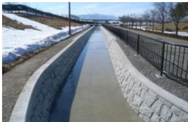
老朽化対策された用水路（砺波市）
