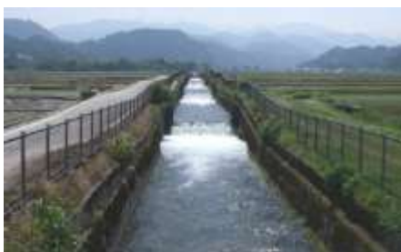
豊富な水資源を有する農業用水路
