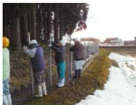
耐雪型侵入防止柵の設置
