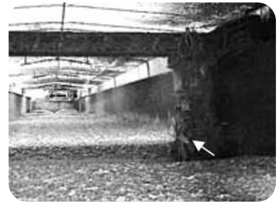
発酵槽とパドル型攪拌装置
