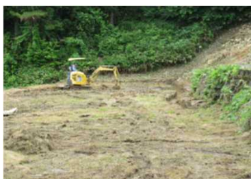
額縁排水状況
