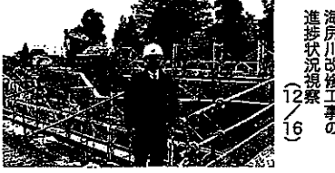
海尻川改修工事の進捗状況視察(12/16)
