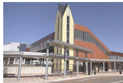
石動駅新駅舎・南北自由通路
