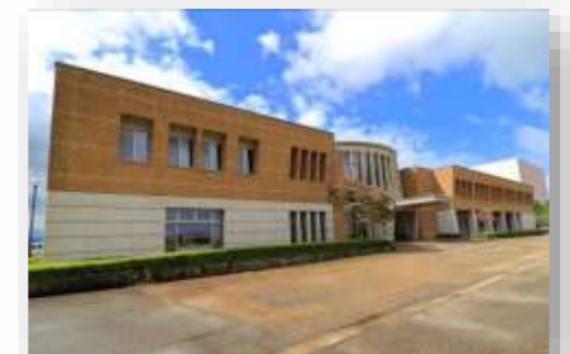
新川センター (黒部市三日市 10) 平成 8 年 4 月 ~ (築 24 年)
