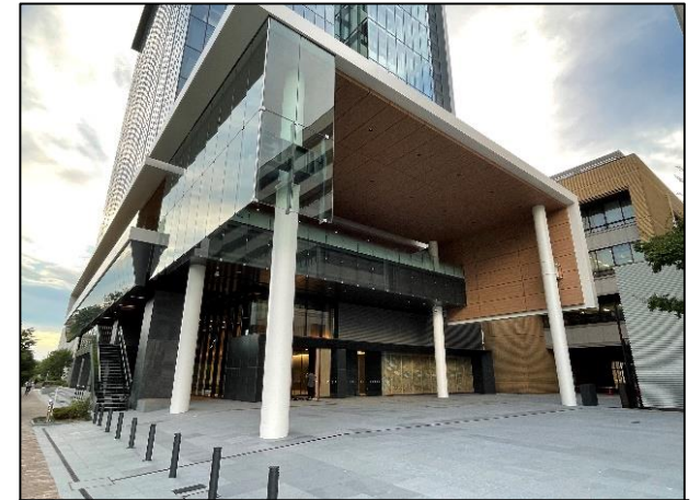
エントランス広場
