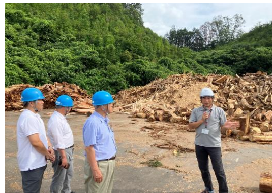
【③真庭バイオマス集積基地第二工場】
