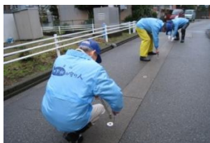
地下水の守り人の活動状況 （消雪設備の点検）
