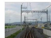
行き違い設備の新設
