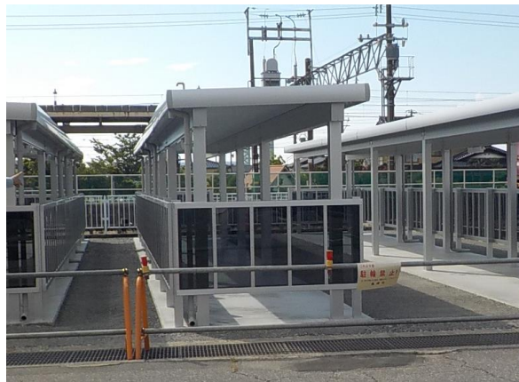
北側駐輪場（改修後）
