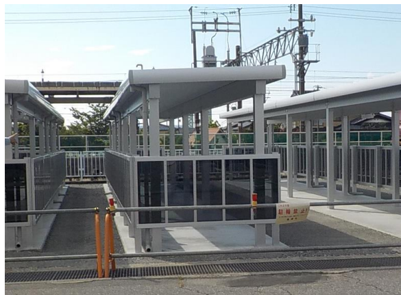
北側駐輪場（改修後）
