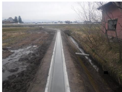
農業用水路の改修
