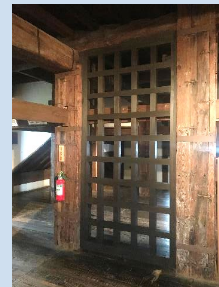
耐震補強・三階の木製格子壁
