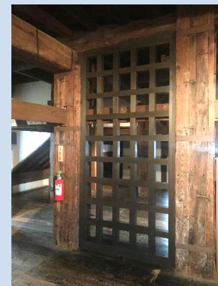
耐震補強・三階の木製格子壁
