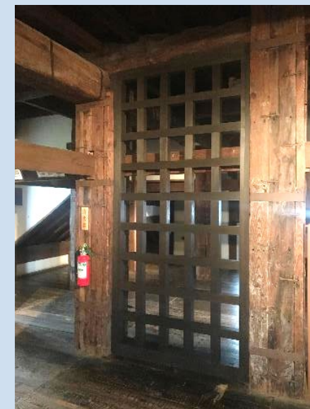
耐震補強・三階の木製格子壁
