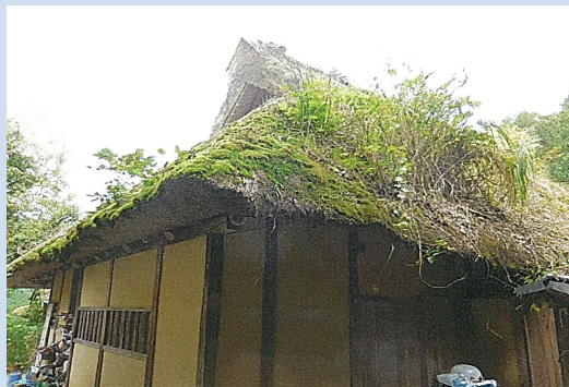
修理前（南東から）
